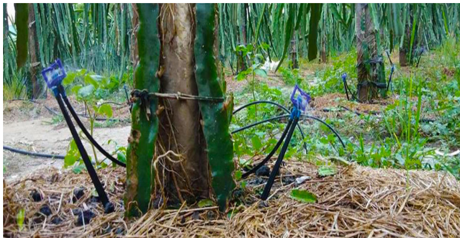
Lắp đặt hệ thống phun sương dưới gốc cây thanh long
